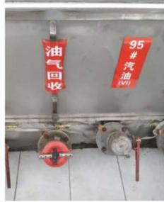
2、加油气回收真空压力阀照片
