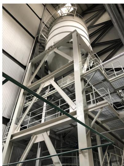
图 3-1-14 烟气净化反应塔
