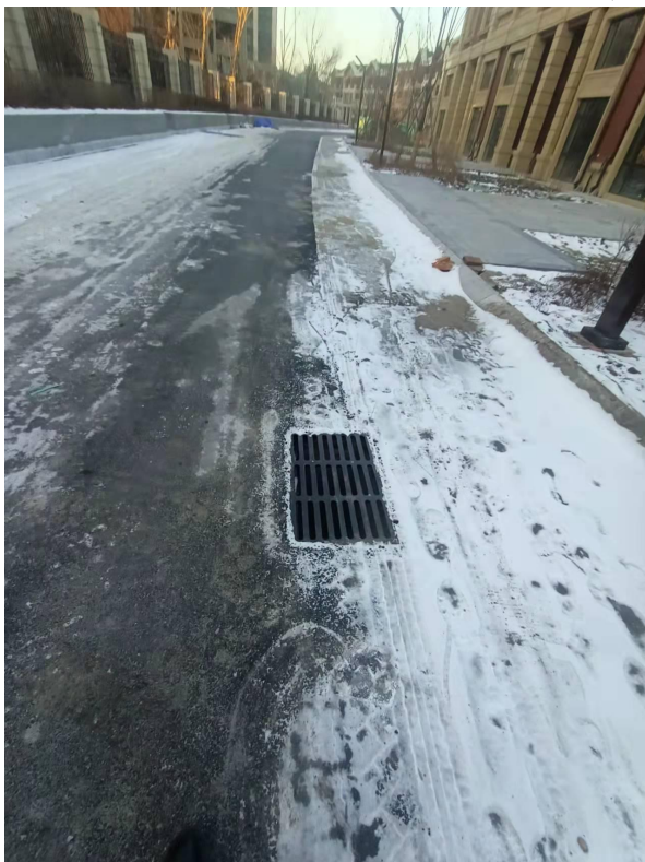
道路两侧雨水管网及雨水口
