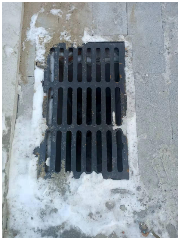
道路两侧雨水管网及雨水口
