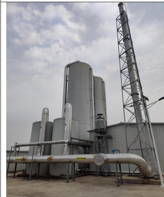
沼气有氧生物脱硫+干法脱硫设施
